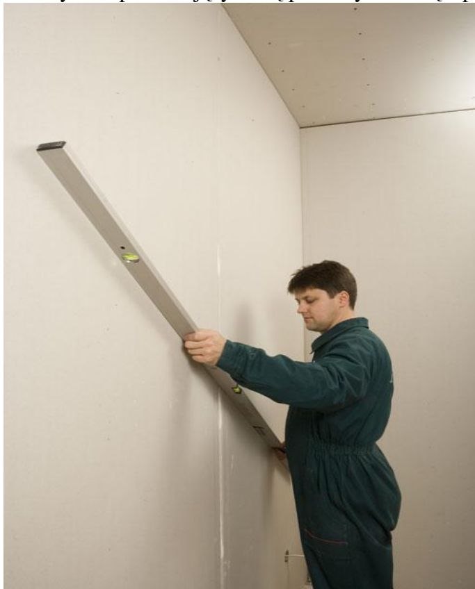
Rys. 4 Sprawdzenie odchylenia powierzchni i krawędzi od kierunku pionowego
