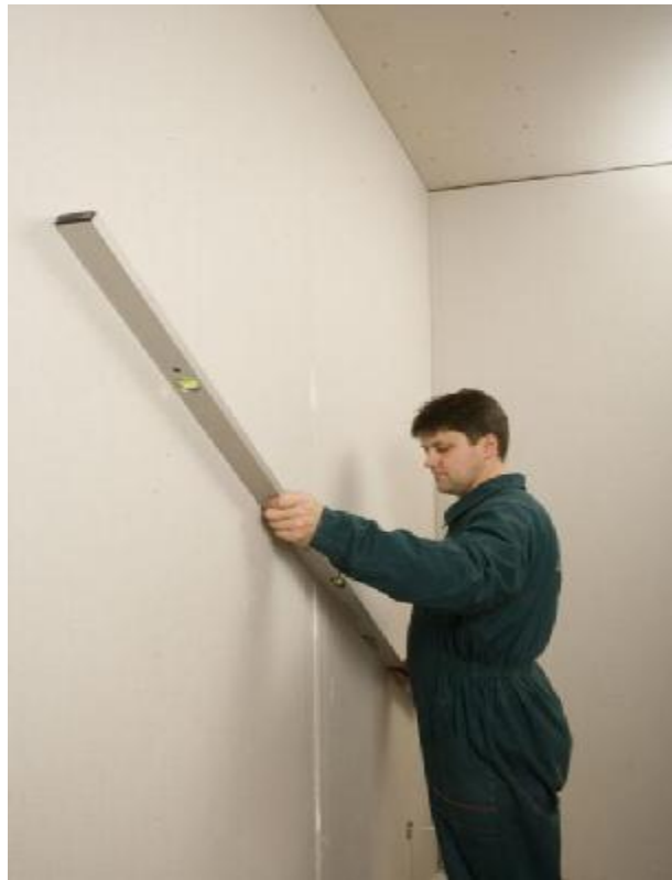
Rys. 11. Sprawdzanie odchylenia powierzchni i krawędzi od kierunku pionowego
