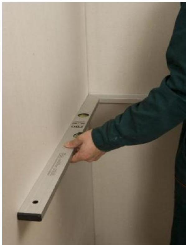
Rys. 12. Sprawdzanie odchylenia przecinających się płaszczyzn od kąta przewidzianego w dokumentacji
